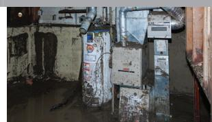
将水电气设备（例如风炉、热水箱）安装在垫高的平台上，或在较高楼层建造一个设备间。
