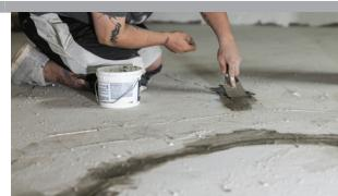
封填好地基墙面和地下室地面上的裂缝。请在当地五金店购买填缝用品。
