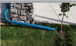
将落水管和集水坑排水管延伸至草坪或植被，远离邻居的房屋。
