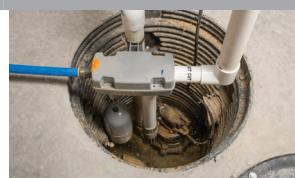
安装并维护带有备用电源的污水泵，和/或考虑添加备用或双污水泵、电池或发电机。
