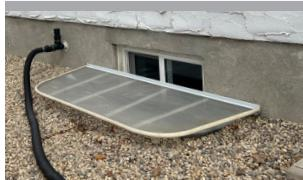
如果有窗井，安装防护罩以防止雨水积聚（确保符合消防安全要求）。
